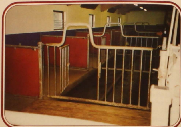
Ungdjursboxarna. Vid behov kan man täcka över skrapgångarna med plankor som synes i bildens underkant.
